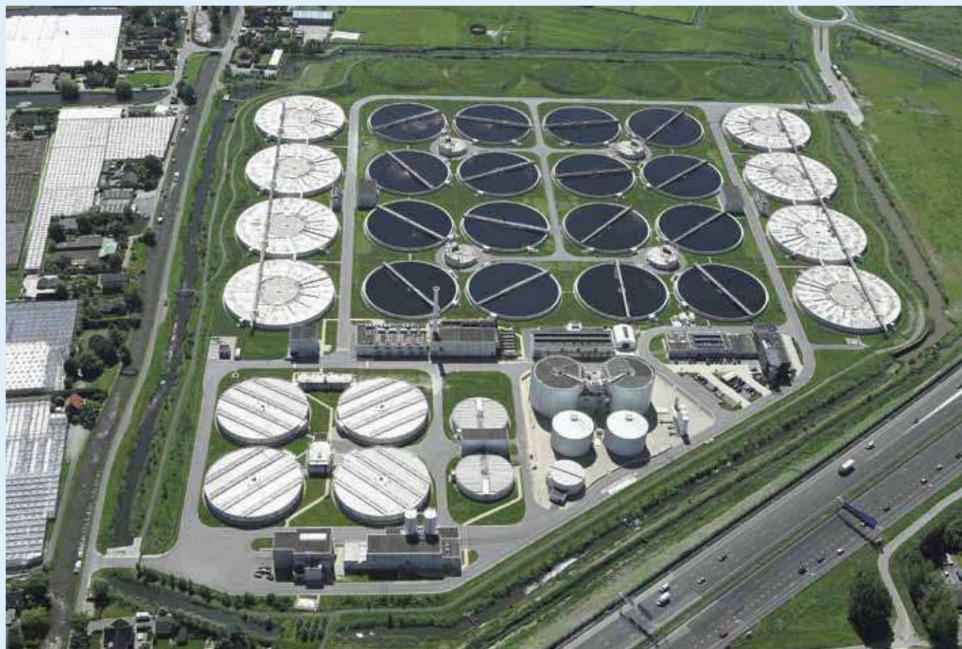
De afvalwaterzuiveringsinstallatie Harnaspolder.
